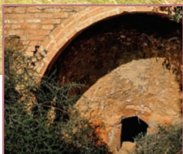
Vue détaillé de la briqueterie
