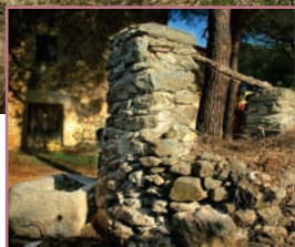
Detalle del pozo de la torre Lloreta
